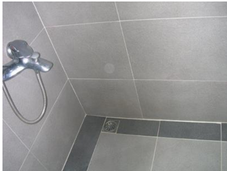
圖 18 採用大型磁磚的地坪置於牆邊的平頭落水頭
