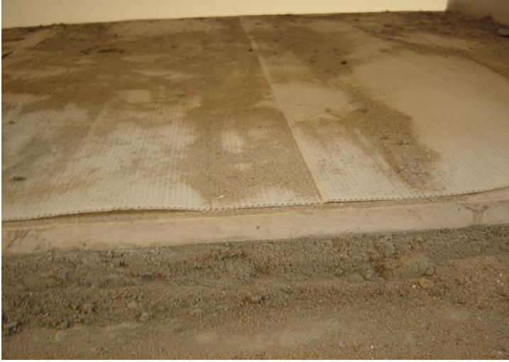
圖 27 以適當的材質保護之完工後地坪
