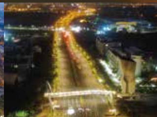
南科實中陸橋
