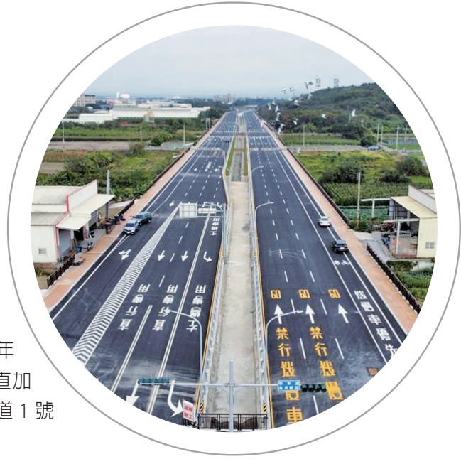
● 南科園區北側 5-40 米道路開通
