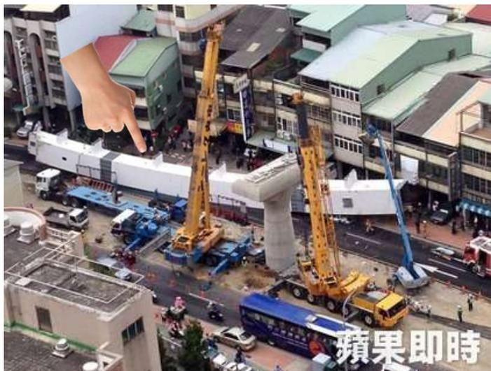
□ 台中市北屯與文心路口的捷運工地正在進行吊掛鋼軌作業時，疑因現場作業疏失，施工中的吊車腳未墊木板分散壓力，導致柏油路面承受不了吊車壓力凹陷，吊車腳整支插進柏油路面，導致正在吊掛鋼軌的吊臂歪斜，從四層樓高處墜下，重甩至朝北屯路264號路面。
