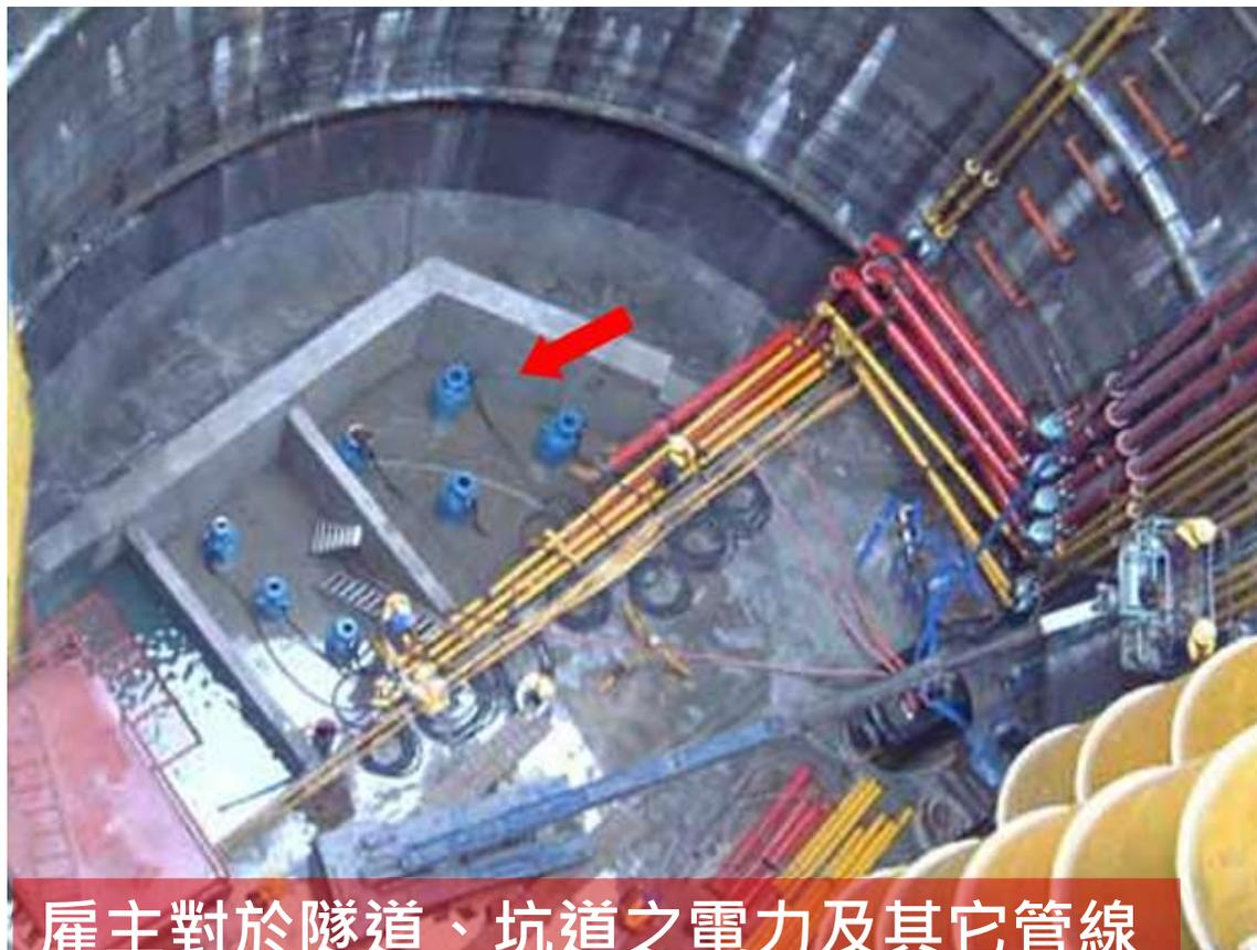
雇主對於隧道、坑道之電力及其它管線系統，應依下列規定辦理：有大量湧水之虞時，應置備足夠抽水能力之設備，並置備設備失效時會發出警報之裝置。
