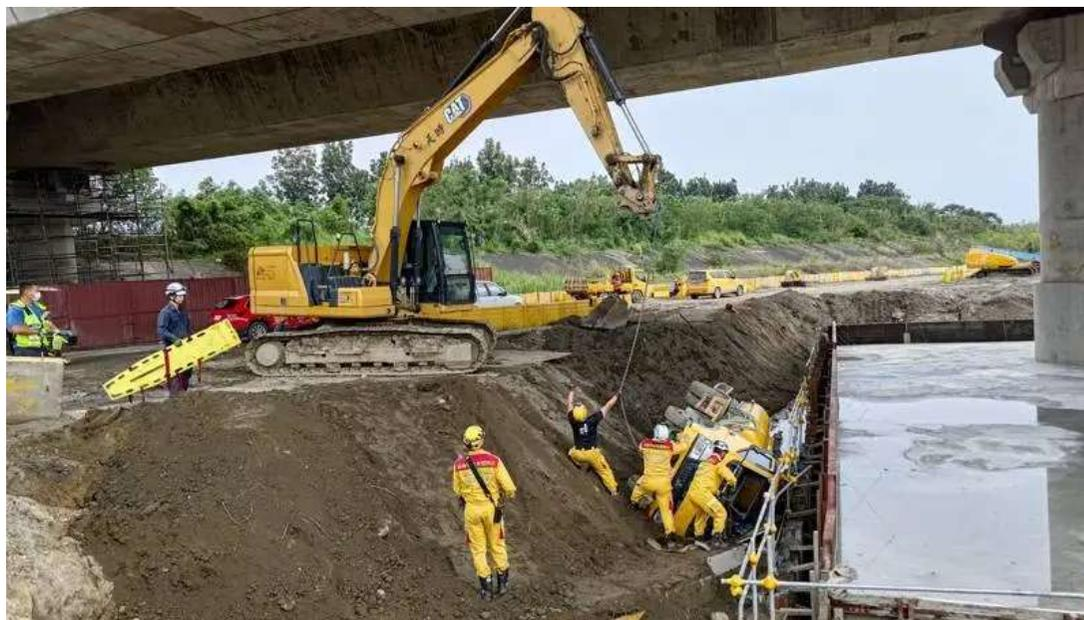
勞工進入開挖面作業，應設擋土支撐
