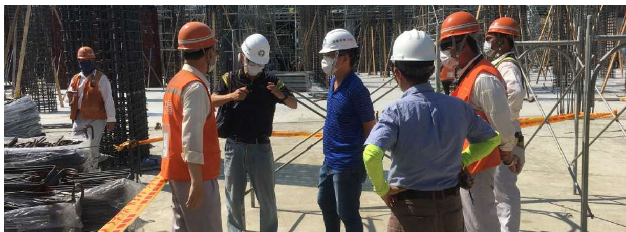
勞動檢查現場照片
