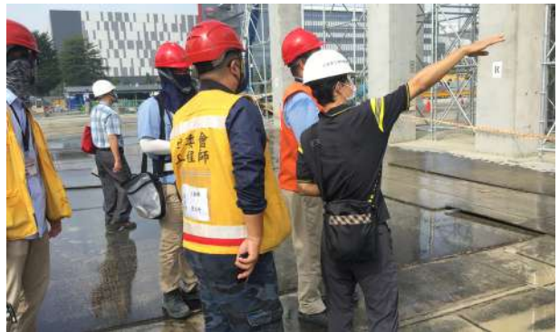
台積電南科先進封裝 2C 廠新建工程 (營造業輔導)
