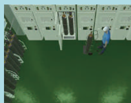
鋼瓶安裝畫面
