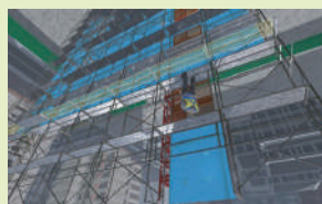
施工架作業體驗畫面
