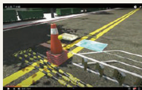
地面設備架設畫面
