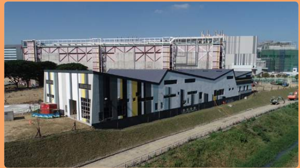
安平再生水配水池及高階處理設施照片
