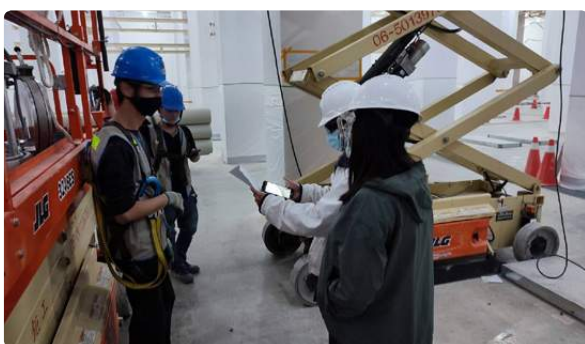
營造業 / 台積 18 廠 P7 新建工程
