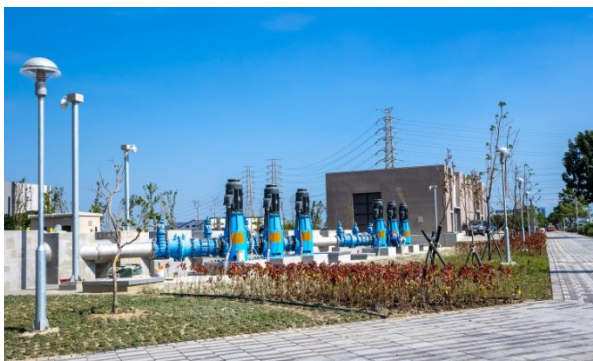
臺南園區第六座配水池完工照
