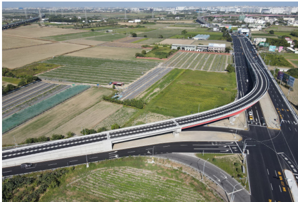
新港社大道轉向工程現地照片
