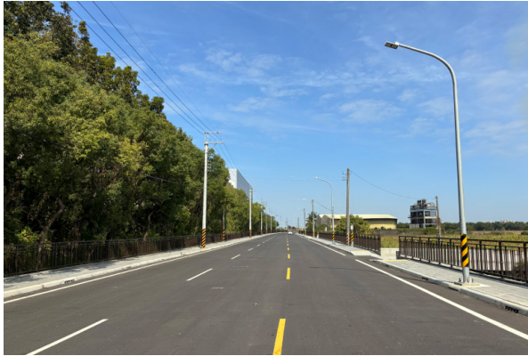
南 137 拓寬工程現地照片
