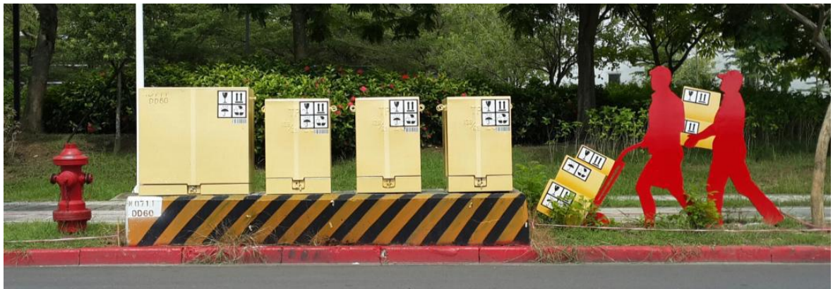
電箱之五：環東路上(3M 廠房前)
