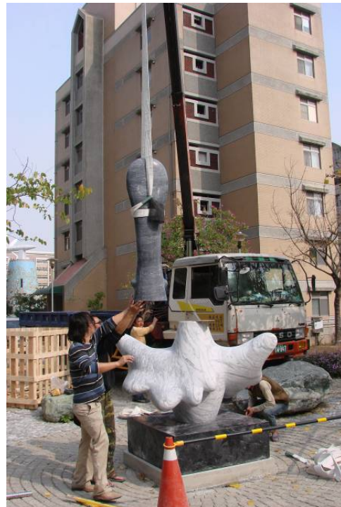
2-3 最後安裝上半部黑色大理石部分膠合固定完成
