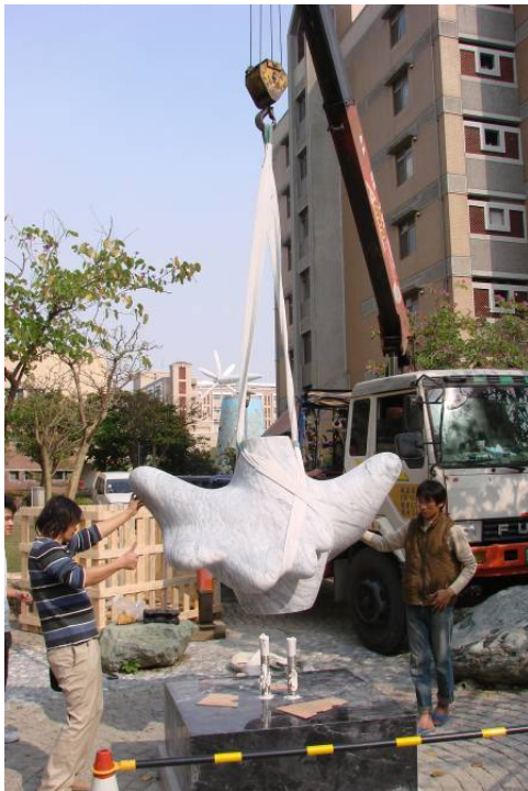
2-2 先安裝基座於地基上，再安裝白色大理石主結構並膠合固定
