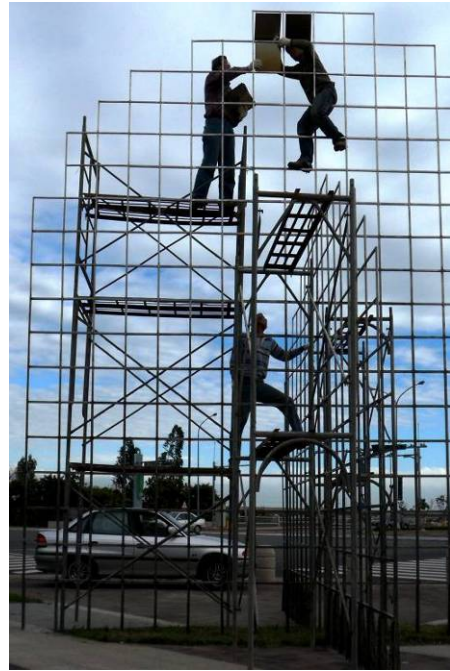
2-2. 框架系統後開始安裝鈦片
