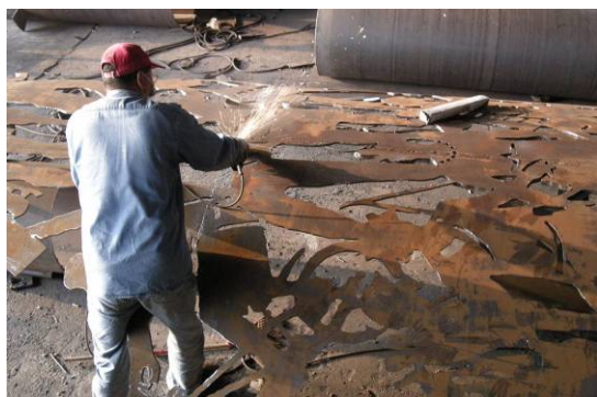
1-4. 碳鋼板表面研磨與防銹處理
