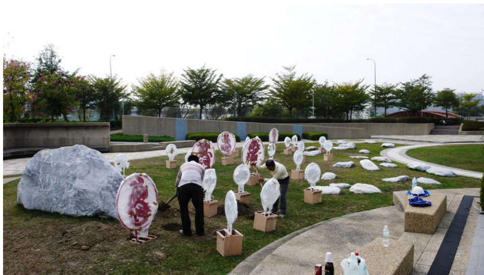
2-1 現場挖地施工
