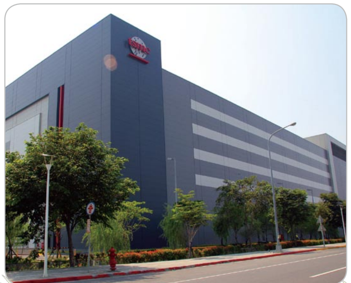
■ 台積電14廠第4期ウエハ工場
