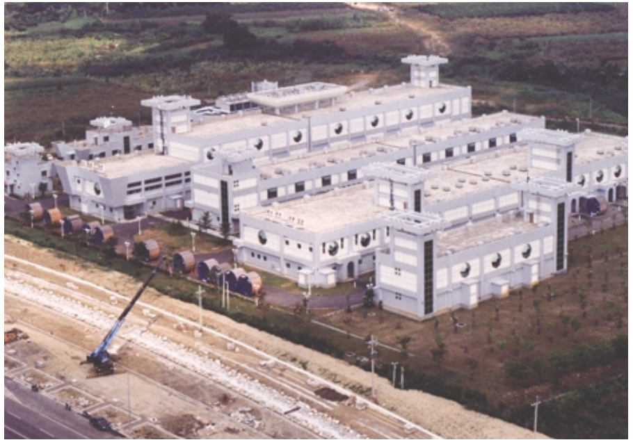
圖 5-4-3 台南園區南科超高壓變電所
