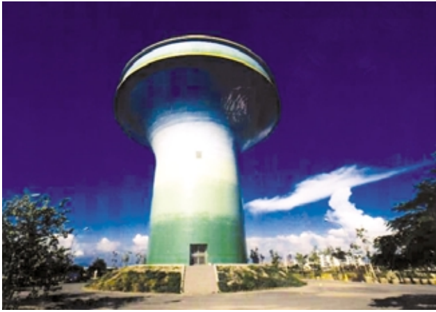
圖 2-3 台南園區第一座工業用水水塔
